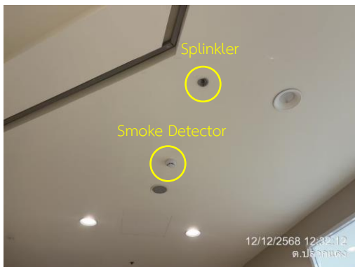
เครื่องตรวจจับ Smoke Detector และ Sprinkler
