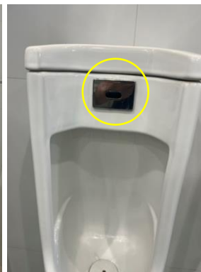
โถปัสสาวะชาย กดน้ำผ่านระบบเซ็นเซอร์
