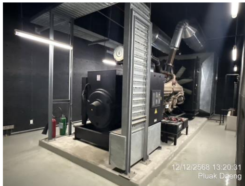
ระบบผลิตไฟฟ้าสำรองภายในอาคาร
