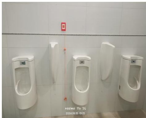
โถปัสสาวะชาย กดน้ำผ่านระบบเซ็นเซอร์
