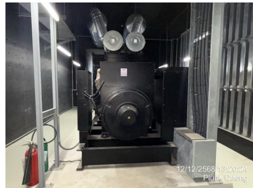
ระบบผลิตไฟฟ้าสำรองภายในอาคาร
