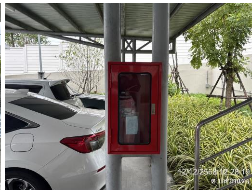
ถังดับเพลิง และตู้เก็บสายดับเพลิง พร้อมวิธีการใช้งานอุปกรณ์ที่ติดตั้งภายในอาคารและภายนอกอาคาร
