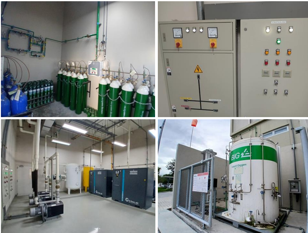
รูปที่ 2-22 ระบบถังท็อก๊าซที่ใช้ในการแพทย์
